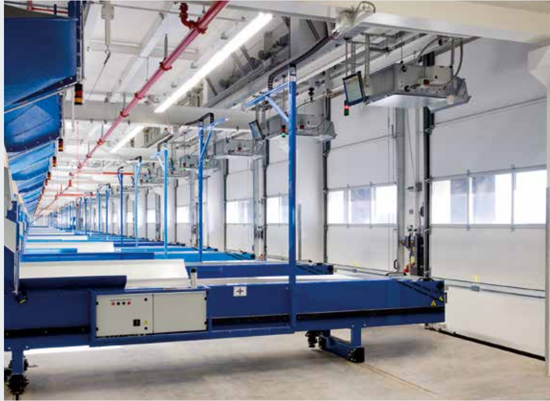
Bölünebilir endüstriyel kapılar özellikle paket kargo firmalarının lojistik merkezleri için geliştirilmiştir.
